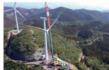
自社所有の大型クレーンを使って行う、風力発電設備の羽根の交換は迫力満点。
