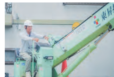
現場では安全第一に努めます
